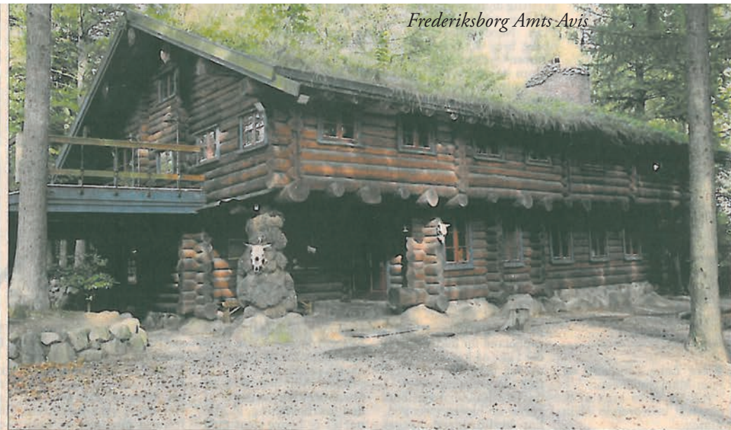
Bassebjerg Blokhus er blevet kåret som årets hus. Huset får æresprisen som en påskønnelse af det samlede anlæg. Ikke specielt den arkitektoniske udformning af byggeriet, eller det store frivillige arbejde og den entusiasme, der er lagt i det, men mere det samlede resultat som en helhed. Foto: Thomas Olsen
