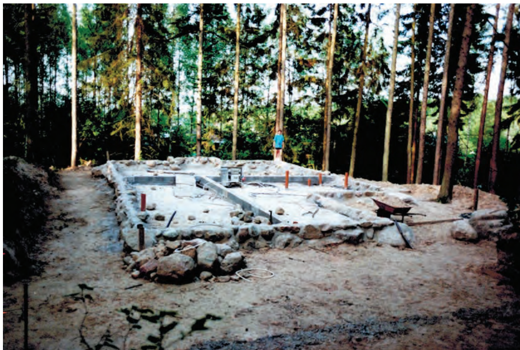
Det færdigstøbte fundament med kampesten.
