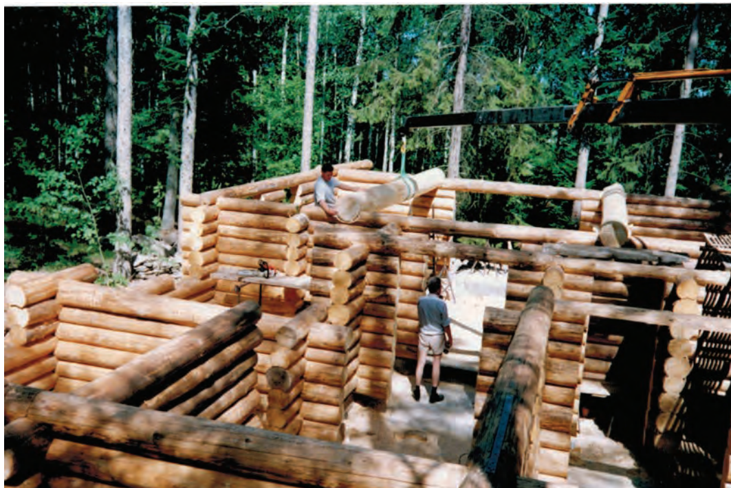
Byggeriet skred frem og stamme for stamme blev skåret til og lagt på plads. Åsene i stuen blev løftet ind med kran.
