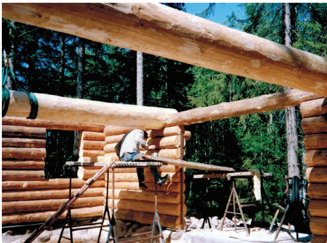
Byggeriet skred frem og stamme for stamme blev skåret til og lagt på plads. Åsene i stuen blev løftet ind med kran.
